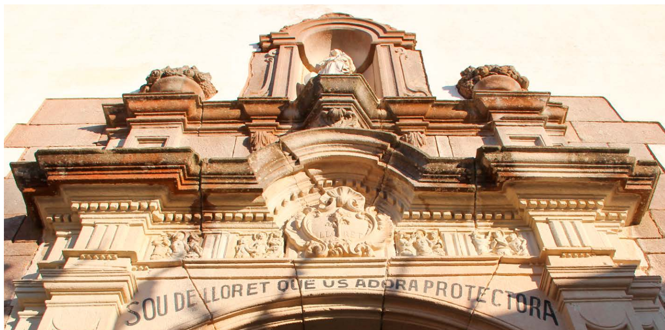
Part superior de la portalada abans de la intervenció
