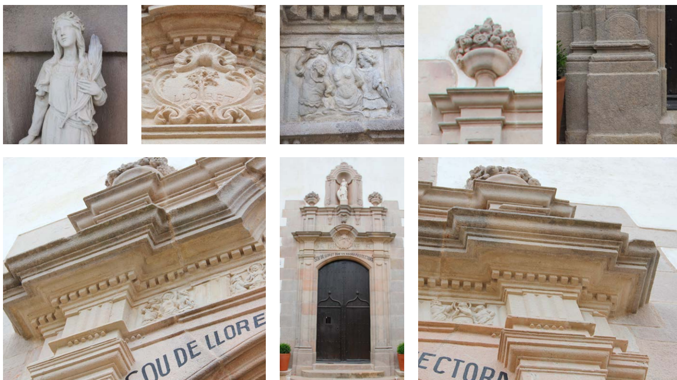
Imatges després de la restauració
